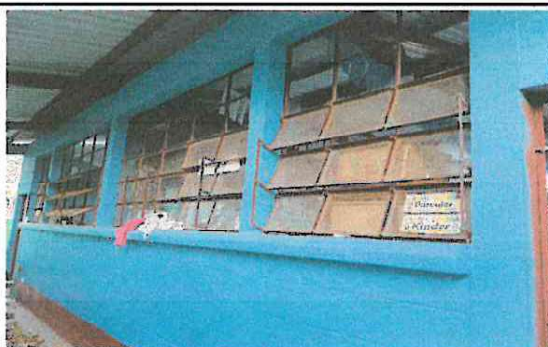
Foto 5: Sustitucion de vidrios
