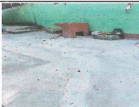
Foto 3: Sustitucion de tuberia linea principal
