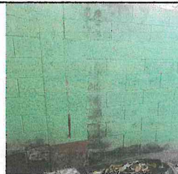
Foto 6: Pintura de muros exteriores e interiores
