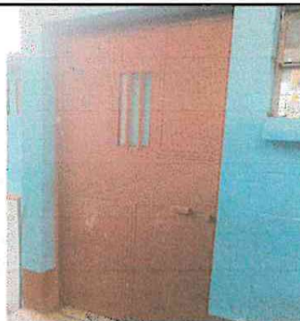
Foto 4: Sustitucion de puerta
