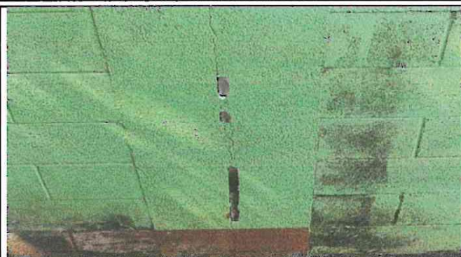
Foto 1: Reparación de muros perimetral de block con tubo ng y malla galvanizadas soleras intermedias y columnas
