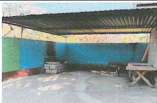
Foto1: Seguimiento de infraestructura de cocina
